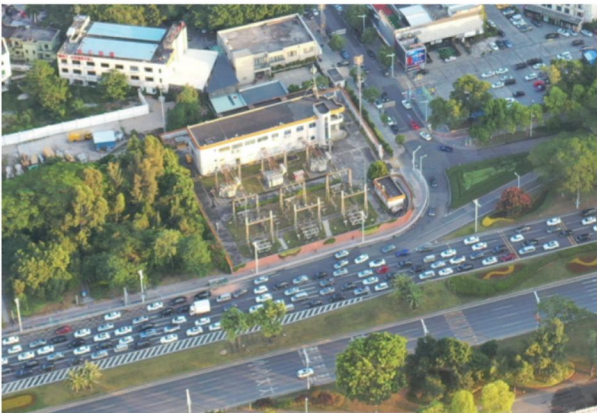
110千伏西平变电站
