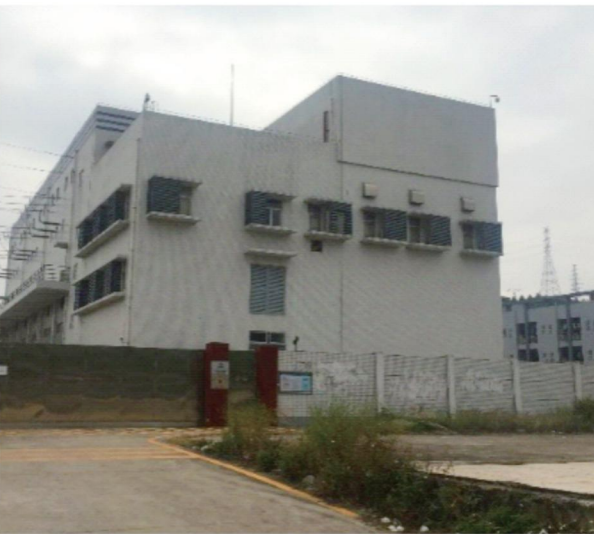
大朗110kV水平站
