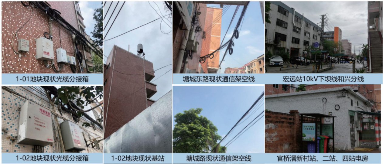
待拆地块内存在10kV公用电缆分接箱、配电站、10kV架空线涉及迁改
