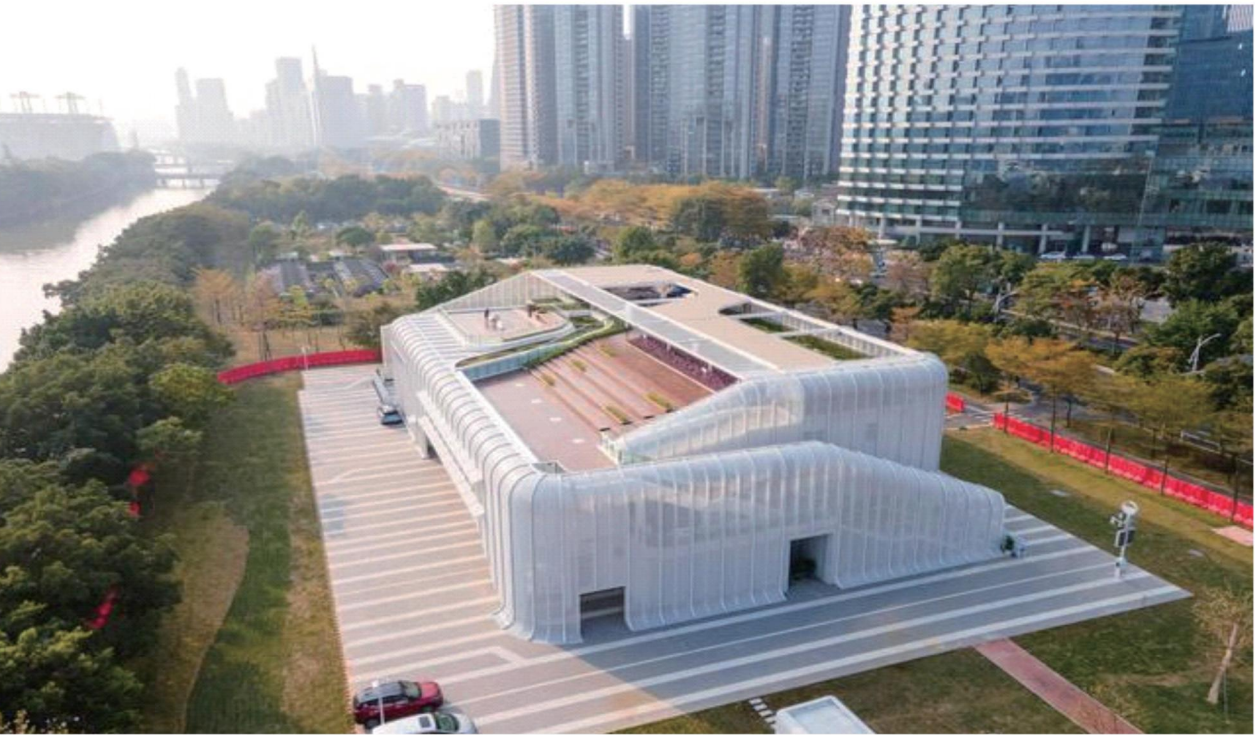
广州110千伏猎桥变电站
