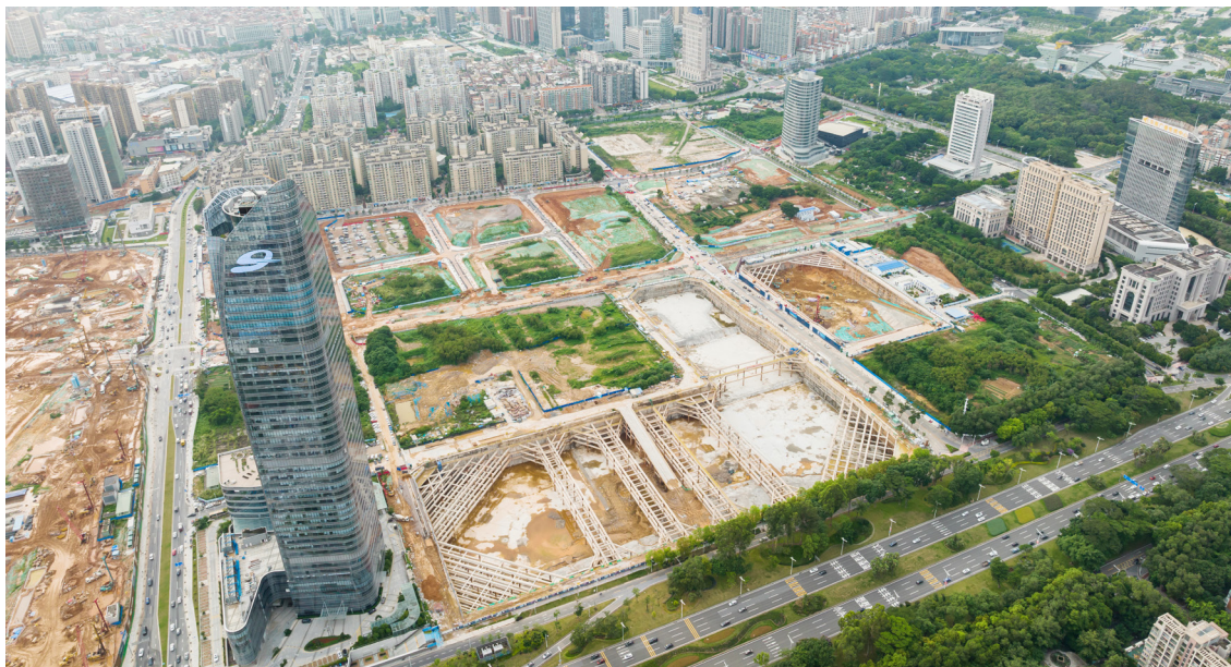
图4 东莞市国际商务区建设现场
