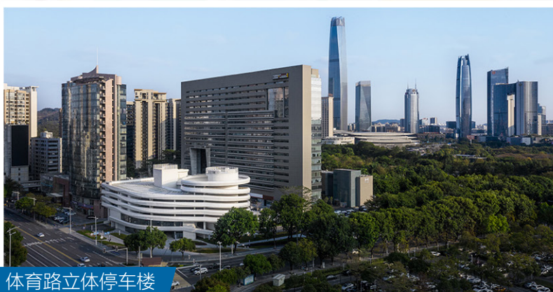
广发片区城市品质提升工程
